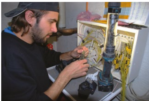
Här "svetsas" inkommande fiber i källaren. På bild Oliver Nordström, OLAB Elektromontage.
